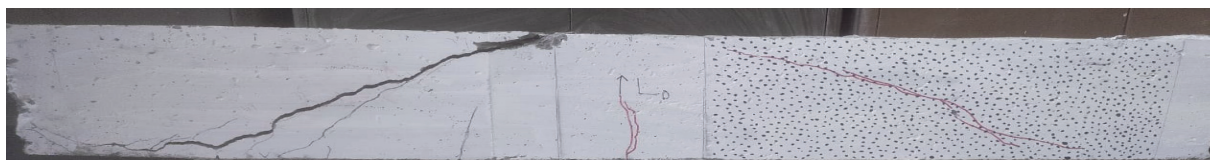
c) L0 Wzorec pęknięcia belki - zniszczenie przez ścinanie c) L0 Beam crack pattern at ultimate – failed in shear
